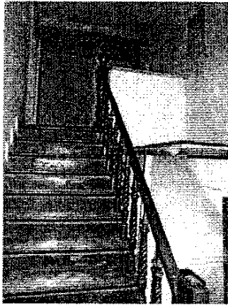
Hofseitig: Altes Treppenhaus
