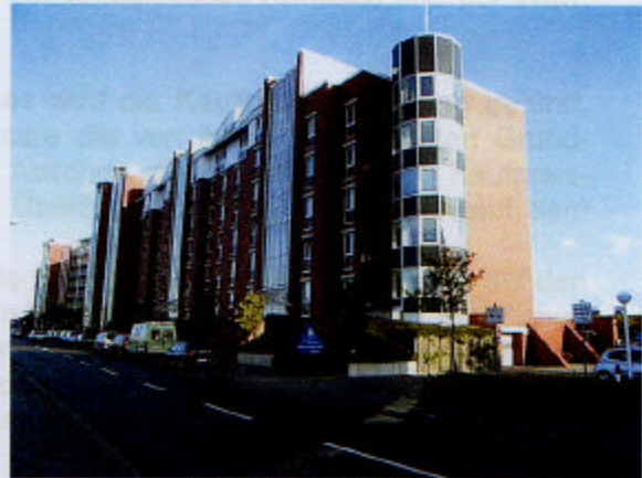
Ansicht von Westen mit Einfahrt Tiefgarage im EG
